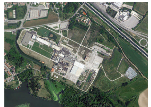
Fig. 12 - Vista aerea zenitale dell'area ex Cartiera Burgo.
