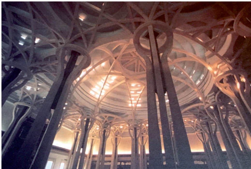
Figg. 6, 7 - Paolo Portoghesi, Vittorio Gigliotti, Sami Mousawi; la Grande Moschea di Roma: particolare esterno e veduta della sala di preghiera (1984).
