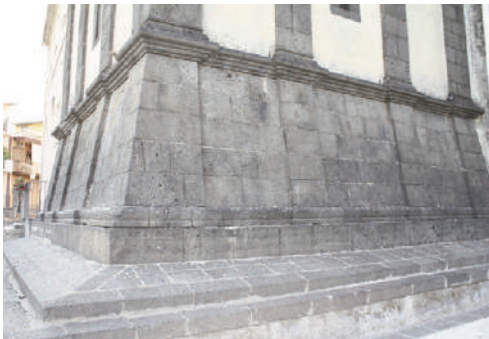
Fig. 14 - Aci San Filippo, particolare del basamento del campanile della Chiesa Madre.
