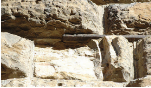
Fig. 9 - Firenze, Palazzo Medici-Riccardi, dettaglio della muratura in pietraforte.
