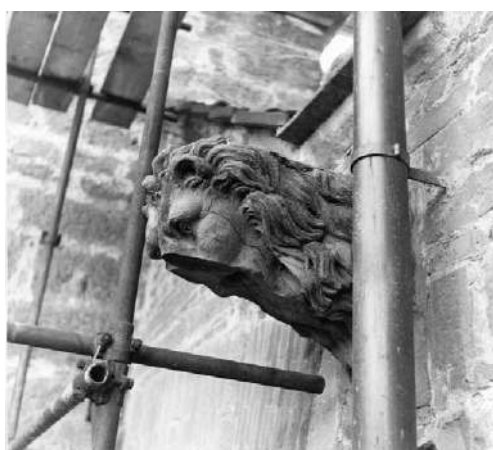
Figg. 6, 7 - Firenze, Basilica di Santa Croce, vista generale e dettaglio di una scultura del fianco sinistro.
