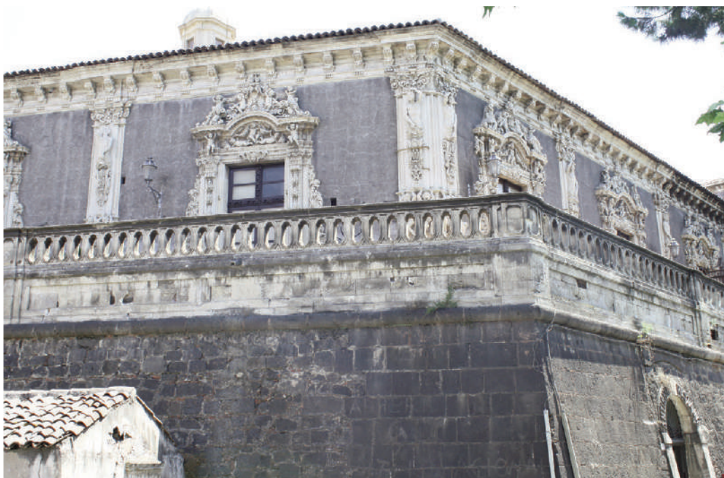
Fig. 13 - Catania, Palazzo Biscari: particolare del fronte verso la Marina.
