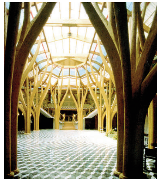
Fig. 15 - Paolo Portoghesi, il Salone Termale nello Stabilimento Il Tettuccio, 1987-1989: struttura in legno lamellare.
