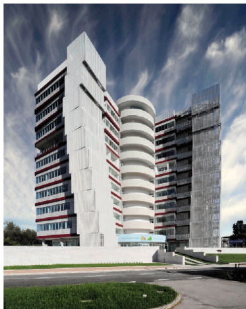
Fig. 19 - Paolo Portoghesi, la Torre dell'Angelo per il Centro di Ricerca Pediatrica di Padova (2008-2012): facciata principale.
