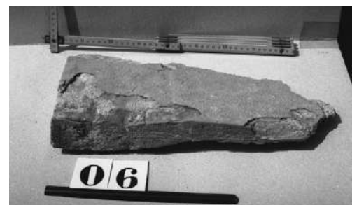
Figg. 10, 11 - Firenze, Palazzo Strozzi: veduta generale e frammento di pietraforte collassato.
