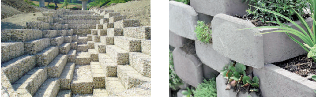
Figg. 5, 6 - Gabbioni metallici e telai prefabbricati in cemento armato.
