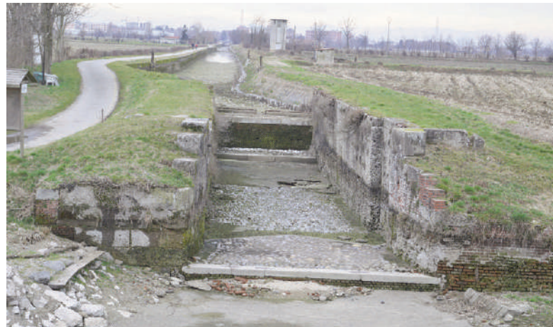
Fig. 3 - Il salto idraulico presso la Conca del Perdono.
