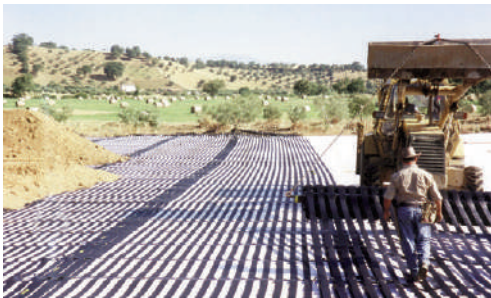
Figg. 1a, 1b - Nastri metallici ancorati a ritentori.
