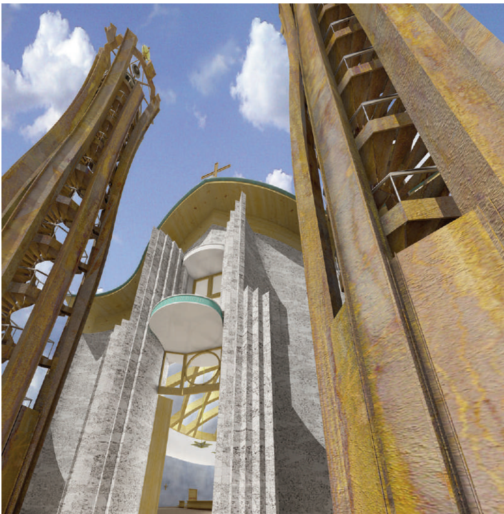
Fig. 21 - Particolare della facciata della Con-cattedrale di San Benedetto con i campanili in corten.
