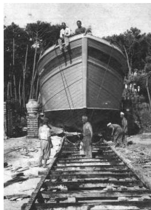
Fig. 6 - Una tipica barca viareggina in costruzione.
