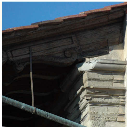
Fig. 17-19 - Firenze, Spedale degli Innocenti. Degrado di un capitello e frammento lapideo.
