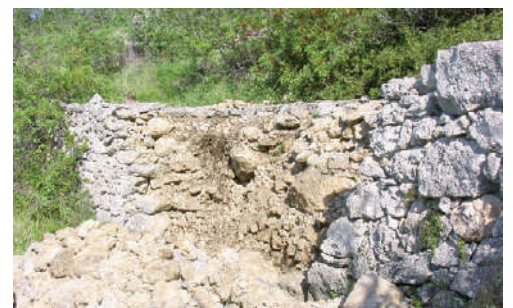
Fig. 7 - Muro di contenimento con il solo paramento esterno in pietra a secco, posteriormente legato con la terra.
