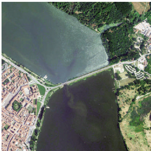
Fig. 3 - Vista aerea zenitale del Ponte di San Giorgio.
