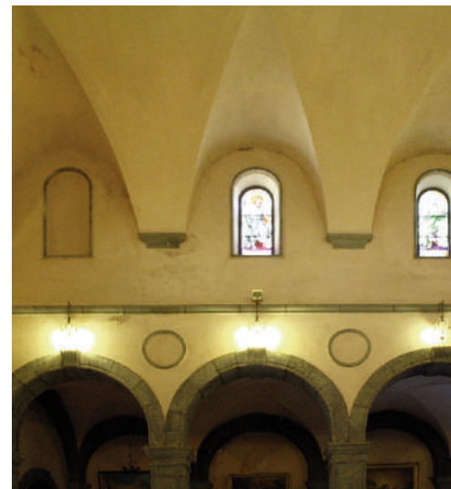
Fig. 10 - Trecastagni, Chiesa Madre: veduta dell'interno.
