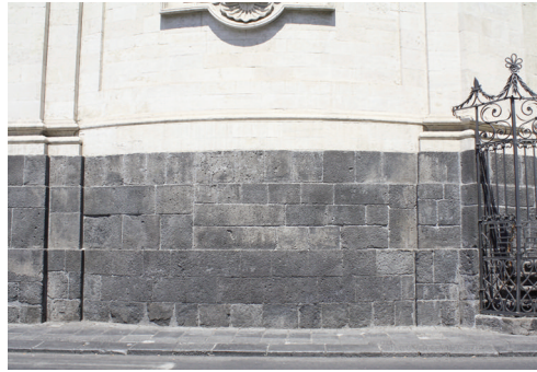
Fig. 15 - Catania, Chiesa della Badia di Sant'Agata: particolare del basamento.
