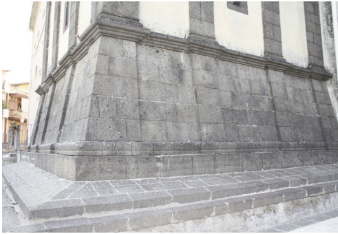
Fig. 14 - Acì San Filippo, particolare del basamento del campanile della Chiesa Madre.
