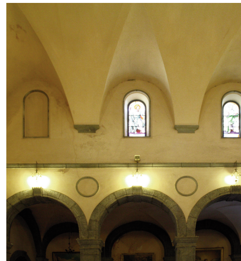
Fig. 10 - Trecastagni, Chiesa Madre: veduta dell'interno.
