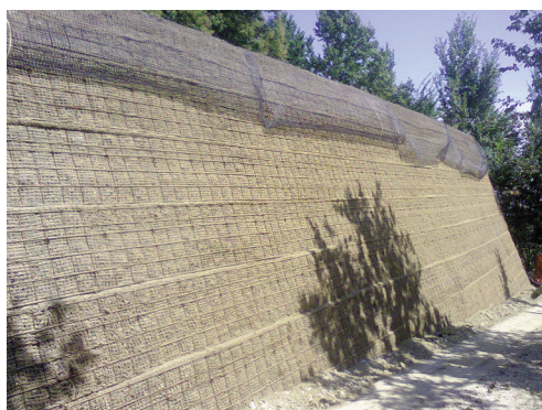
Figg. 2a e 2b - Intrecciati di juta con ancoraggi in legno.
