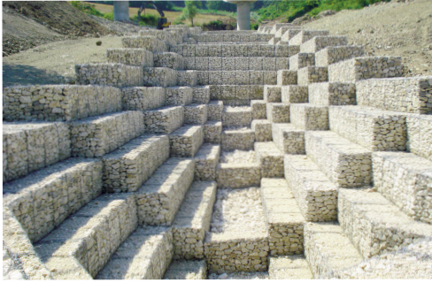
Figg. 5, 6 - Gabbioni metallici e telai prefabbricati in cemento armato.
