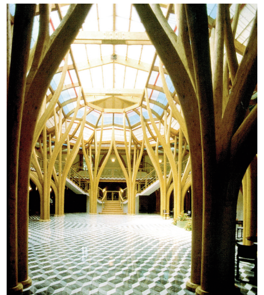
Fig. 15 - Paolo Portoghesi, il Salone Termale nello Stabilimento Il Tettuccio, 1987-1989: struttura in legno lamellare.
