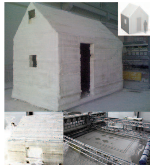
Fig. 30 - Un'abitazione stampata con la D-Shape su progetto di Marco Ferreri, esposta e commissionata dalla Triennale Milano nel 2010. (© D-Shape.com).
