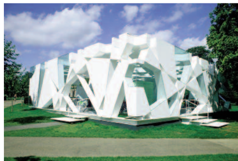
Fig. 8 - Il Serpentine Gallery Pavilion a Londra (Ito, Balmond e Arup, 2002).
