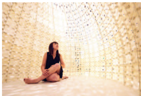
Fig. 35 - Saltygloo è una stanza realizzata con componenti modulari che richiamano la forma cristallina del sale e che sono ruotati e aggregati in modo casuale; la miscela, composta da sale e colla, è resistente, impermeabile, leggera, traslucida ed economica (© Rael, San Fratello e Lee, 2013).
