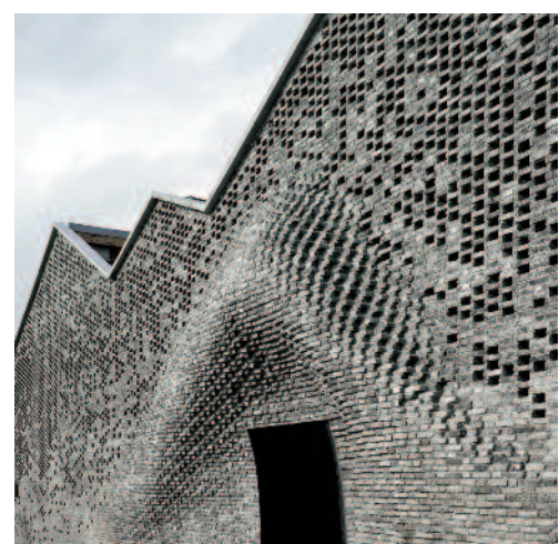
Figg. 11, 12 - Una quinta di mattoni, la cui tessitura è assemblata da un robot (© NCCR Digital Fabrication), e la Galleria d'arte nel Shanghai's West Bund District, il cui prospetto con trama in mattoni è stato posato in opera da un robot (Archi-Union Architects, 2016).
