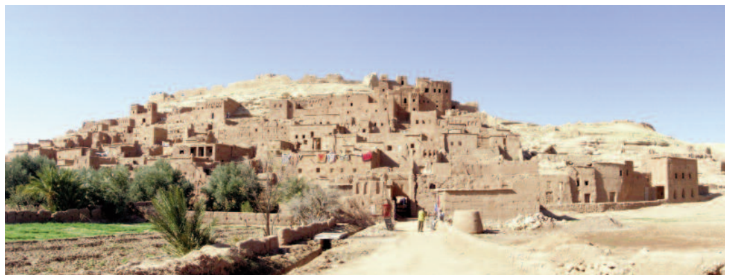
Fig. 31 - Ait Benhaddou in Marocco, dove tutti gli edifici sono costruiti con argilla mista a fibra tamarindica (© WASP Team).
