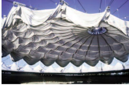
Fig. 12 - Velario centrale con dispiegamento radiale al Rothenbaum stadium di Amburgo.
