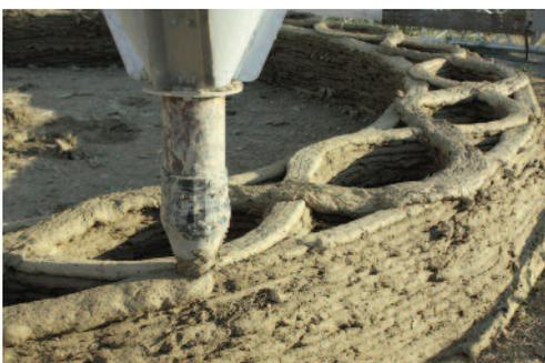
Figg. 33, 34 - La presentazione della BigDelta a Massa Lombarda (RA) nel 2015 e la stampa dimostrativa di un volume circolare: altezza e diametro del manufatto rispettivamente m 2,70 e 5,140 di materiale distribuito su 135 layer, m<sup>3</sup> 2 d'acqua e 200 Kwh di energia consumati (© WASP Team).
